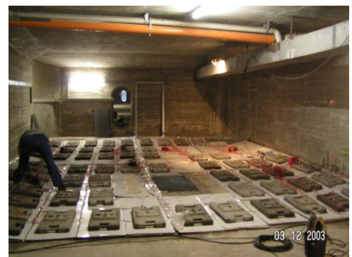
Chloridzug auf dem Hohlkastenboden einer Autobahnbrücke (CITec GmbH)
