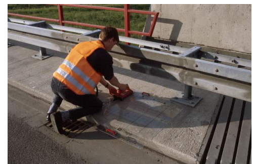
Bewehrungsscan mit HILTI Ferroskan
